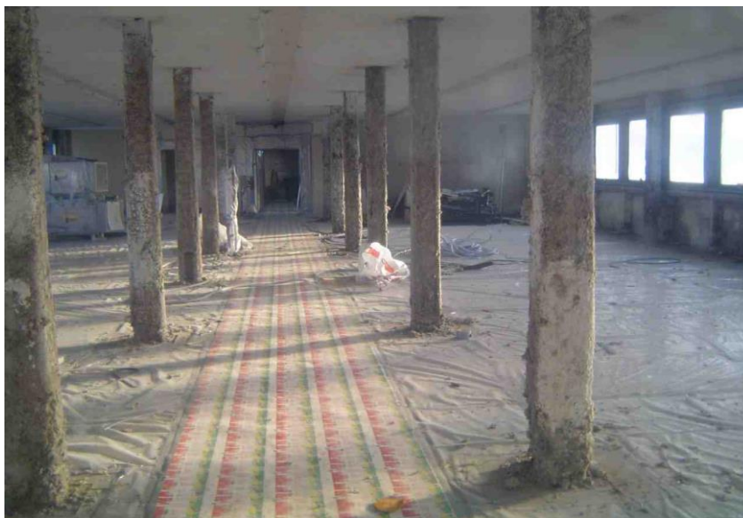
Graphique 3 : Photographie prise dans une aile de l'immeuble pendant l'opération de désamiantage de 2003-2004
